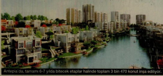
Antepia'da, tamamı 6-7 yılda bitecek etaplar halinde toplam 3 bin 470 konut inşa ediliyor.
